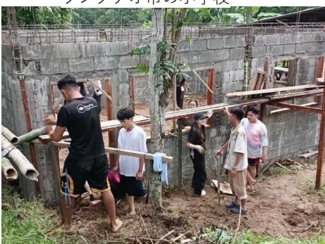
現地での教室建設の様子
