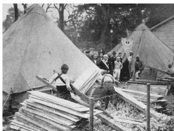
修養団救護部による バラック建築工事
